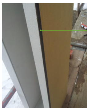
GUTEX Fugendichtband BG 1 (adhesive sealing strip)
